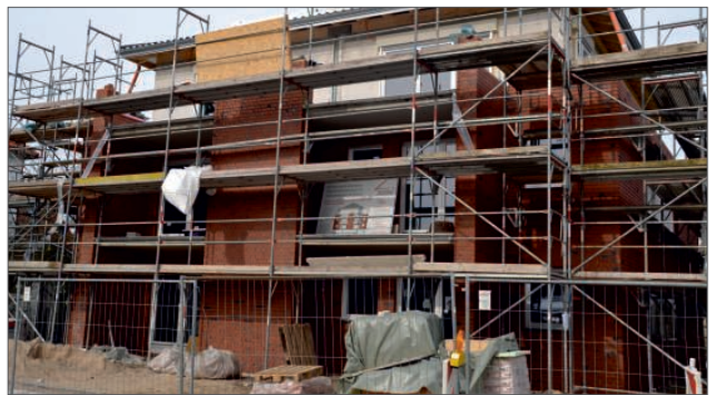
... das Bauvorhaben in der Schulstraße 2, das im Sommer fertig gestellt sein soll.
