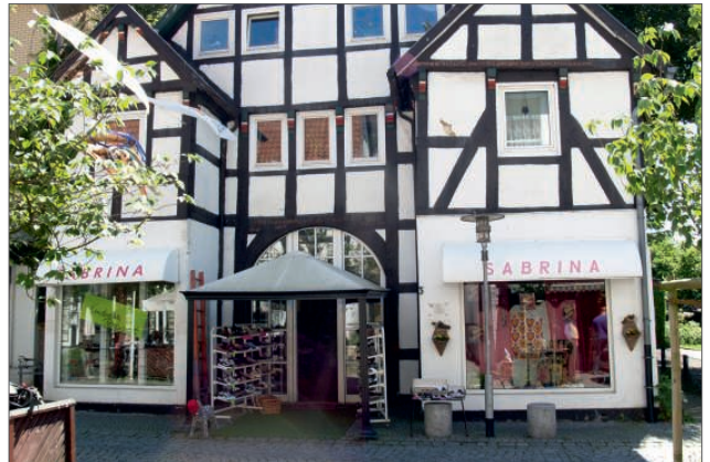
Im Juli zieht „Schuhmoden Sabrina“ von der Rosenstraße 3 in die Bahnhofstraße 18 - direkt an den Ronchinplatz.
