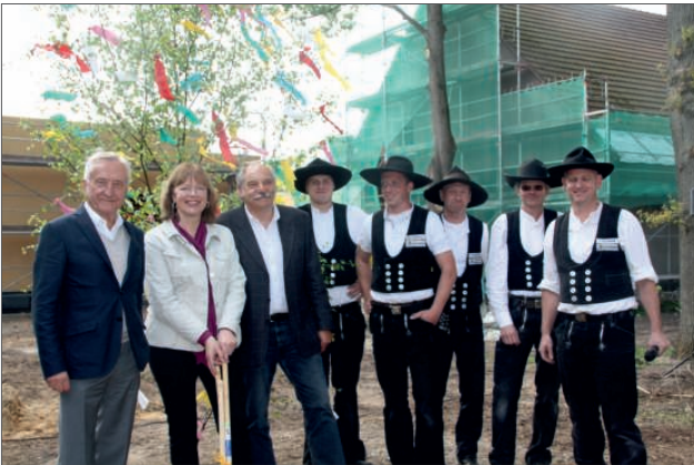
Richtfest der neuen Kita: mit Gerhard Weber, Bürgermeisterin Anne Rodenbrock-Wesselmann, Architekt Klaus-Peter Spannhoff sowie die Zimmerleute der Zimmerei Heggemann.
