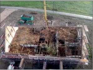
*Nach Abbau des maroden Dachstuhls offenbart sich der darunter liegende verfallene Zustand.*
