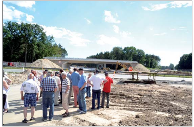
Brücke Alleestraße: hier wird demnächst der Verkehr provisorisch auf der zukünftigen Autobahntrasse entlang geleitet.
