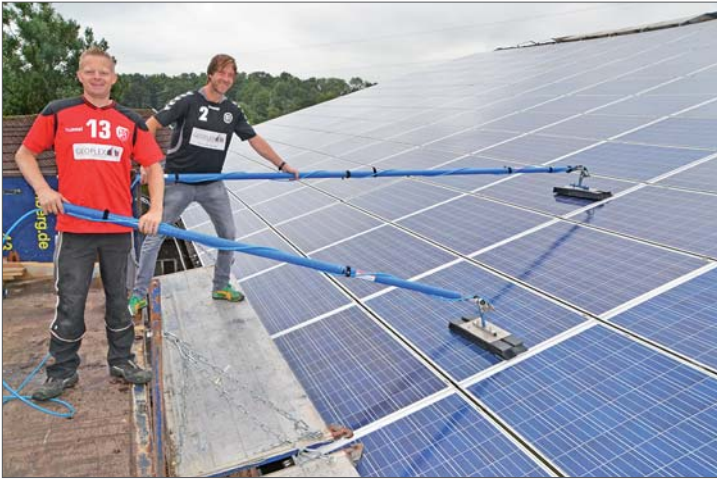
Besonders bei weniger geneigten Dachflächen und in landwirtschaftlichen Betrieben ist eine regelmäßige Reinigung der Module wichtig, empfehlen die Fachleute André Fiechuch (re) und Jan Fischer, die dem Dreck mit speziellen Reinigungsgeräten zu Leibe rücken.
