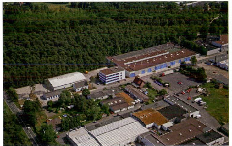
Der Gebäudekomplex in der Almestraße in Bielefeld-Ummeln bietet reichlich Lagerkapazität.
